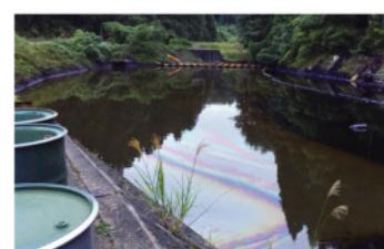
沈砂池のはとんどが黒い原油で覆われています。ポンプで回収した原油は、油水分離槽を通してドラム缶にいれ処分。
