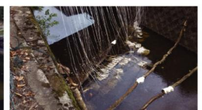
朝日川下流の五明橋付近に設置されたオイルマットとオイルフェンス。ここで原油流出をくいとめて、下流の東大通川への流出を防止。
