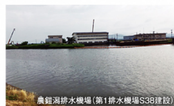
農用排水機場(第1排水機場S38建設)
